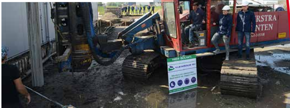
De eerste paal van de nieuwbouw is geslagen.
